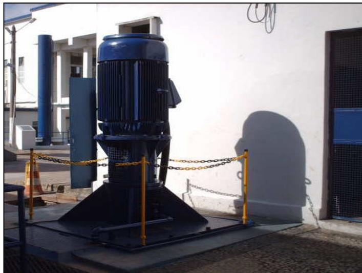
Figura 7 - Moto-bomba Worthington 36 KLD. Fonte: Arquivos de fotos da empresa
